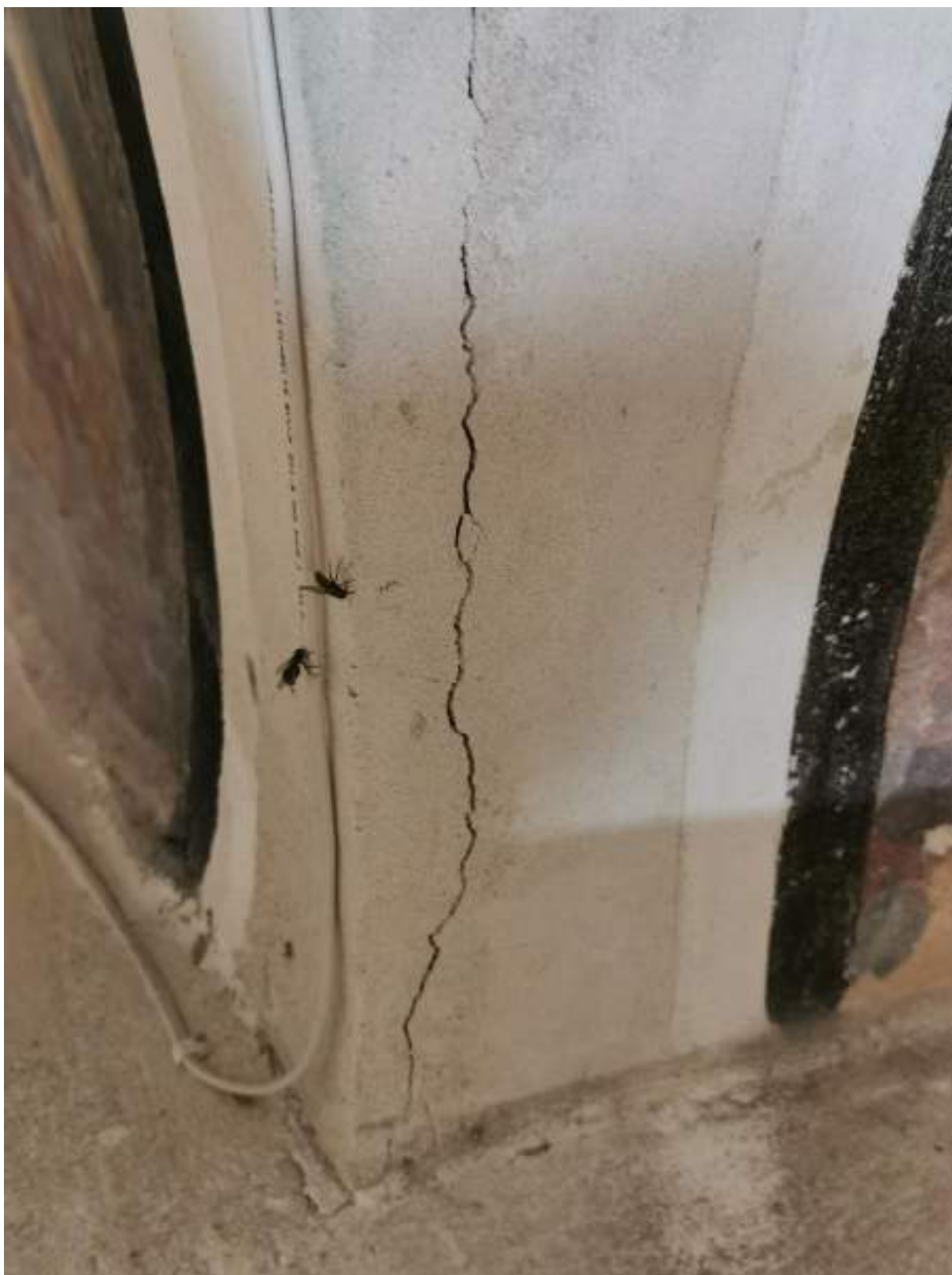
29. Šiaurės vakarų skliauto kampas, tinko įtrūkimas, tapybos ištrupėjimai, nešvarumai, vabzdžiai.
