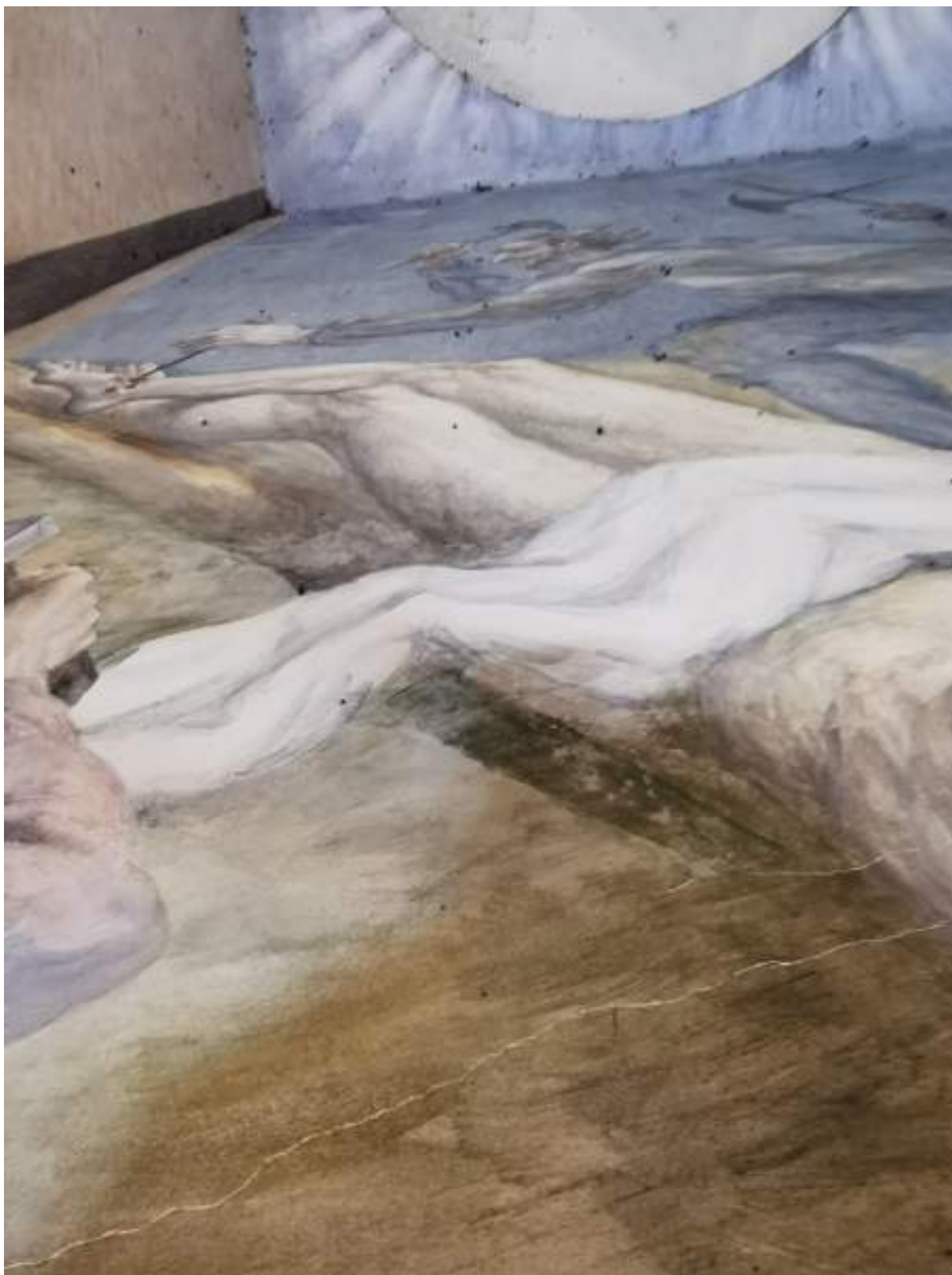
27. Kompozicija „Jēzus prikalamas ant kryžiaus“, detalē, tinko įtrūkimas virš arkos, tapybos pabalimai, nešvarumai, vabzdžiai.
