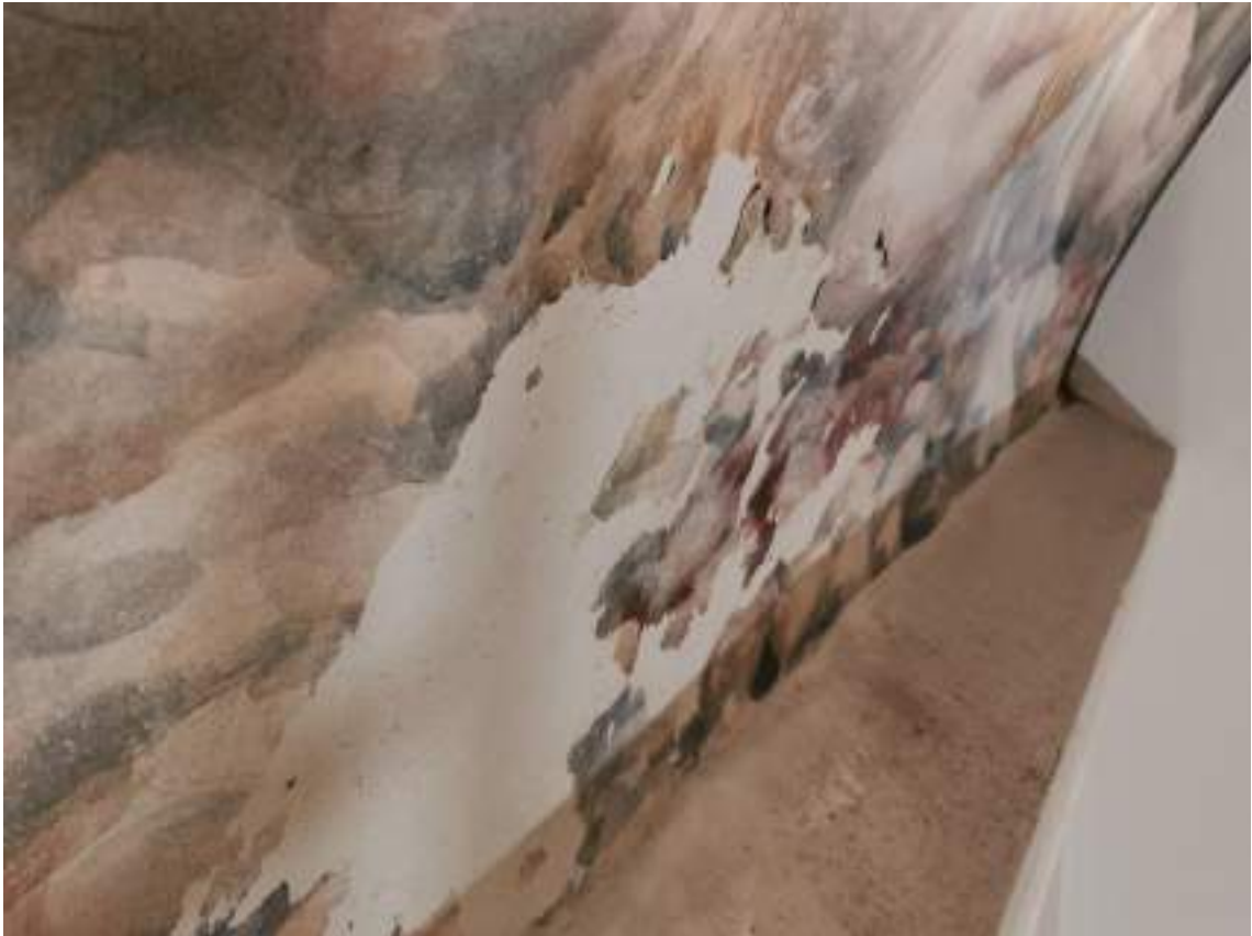
15. Kompozicija „Pieta“, detalė, pažeistas druskų, atšokęs, trupantis freskos sluoksnis.
