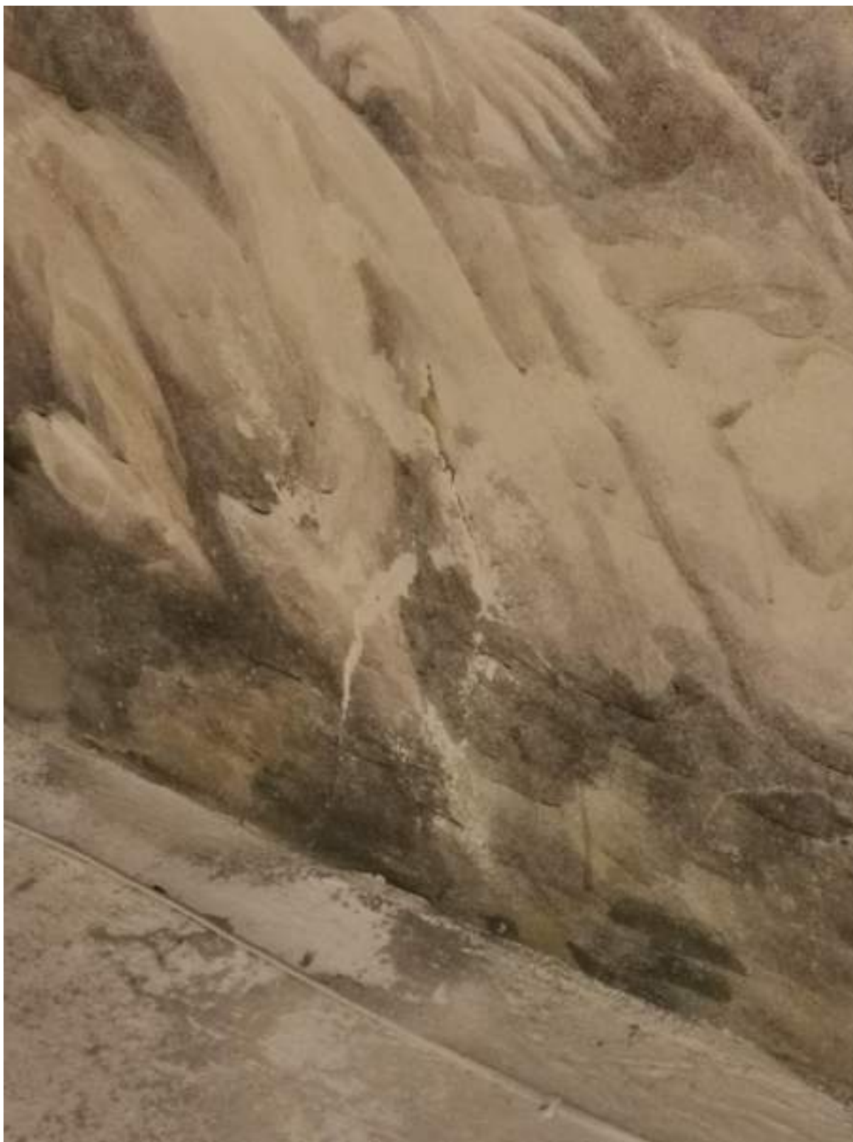
17. Kompozicija „Žudynės“, detalė, pažeistas druskų, atšokęs, trupantis freskos sluoksnis.
