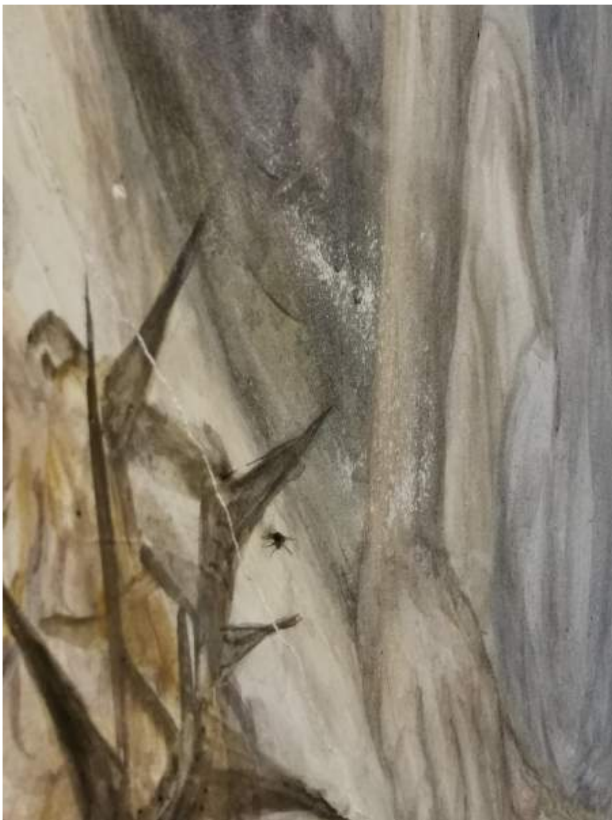
28. Kompozīcija „Jēzus prikalamas ant krūžiaus“, detalē, tīnko įtrūkimas virš arkos, tapybos ištrupėjimai, nešvarumai, vabzdžiai.
