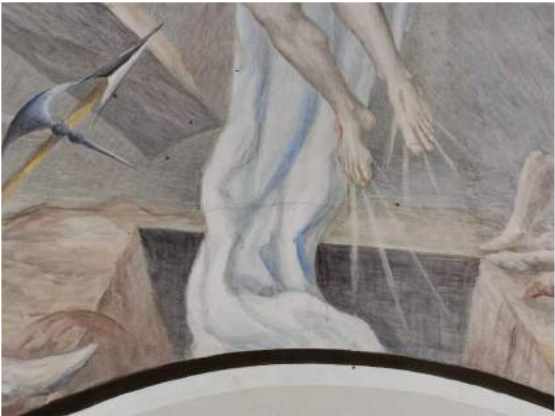
26. Kompozicija „Prisikėlimas“, detalė, tinko įtrūkimas virš arkos, nešvarumai.
