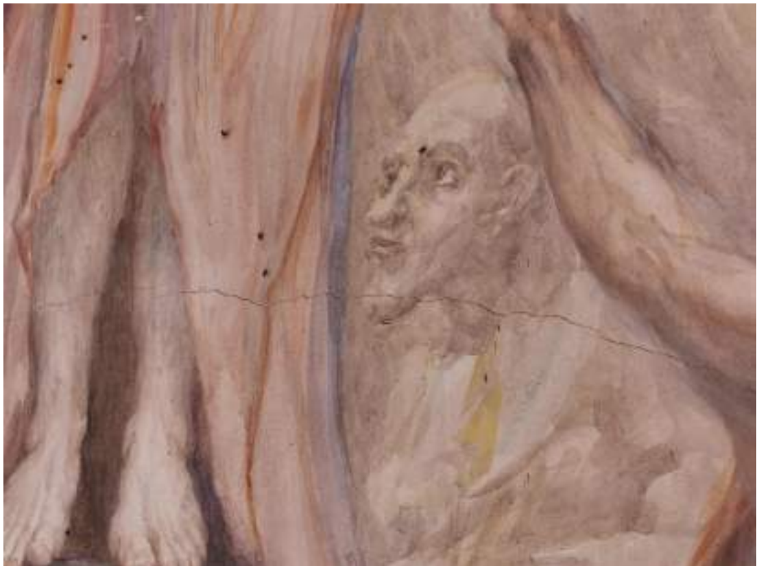
24. Kompozicija „Jėzus nuplakamas“, detalė, tinko įtrūkimas virš arkos.
