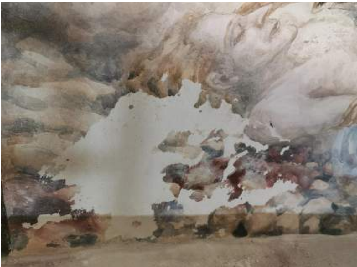
16. Kompozicija „Pieta“, detalė, pažeistas druskų, atšokęs, trupantis freskos sluoksnis.
