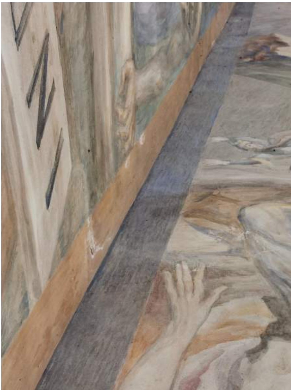
35. Scenų „Jēzus prikalamas ant kryžiaus“ ir „Priesikēlimas“ kampas, tapybos ištrupējimai, tinko įtrūkimai, nešvarumai.
